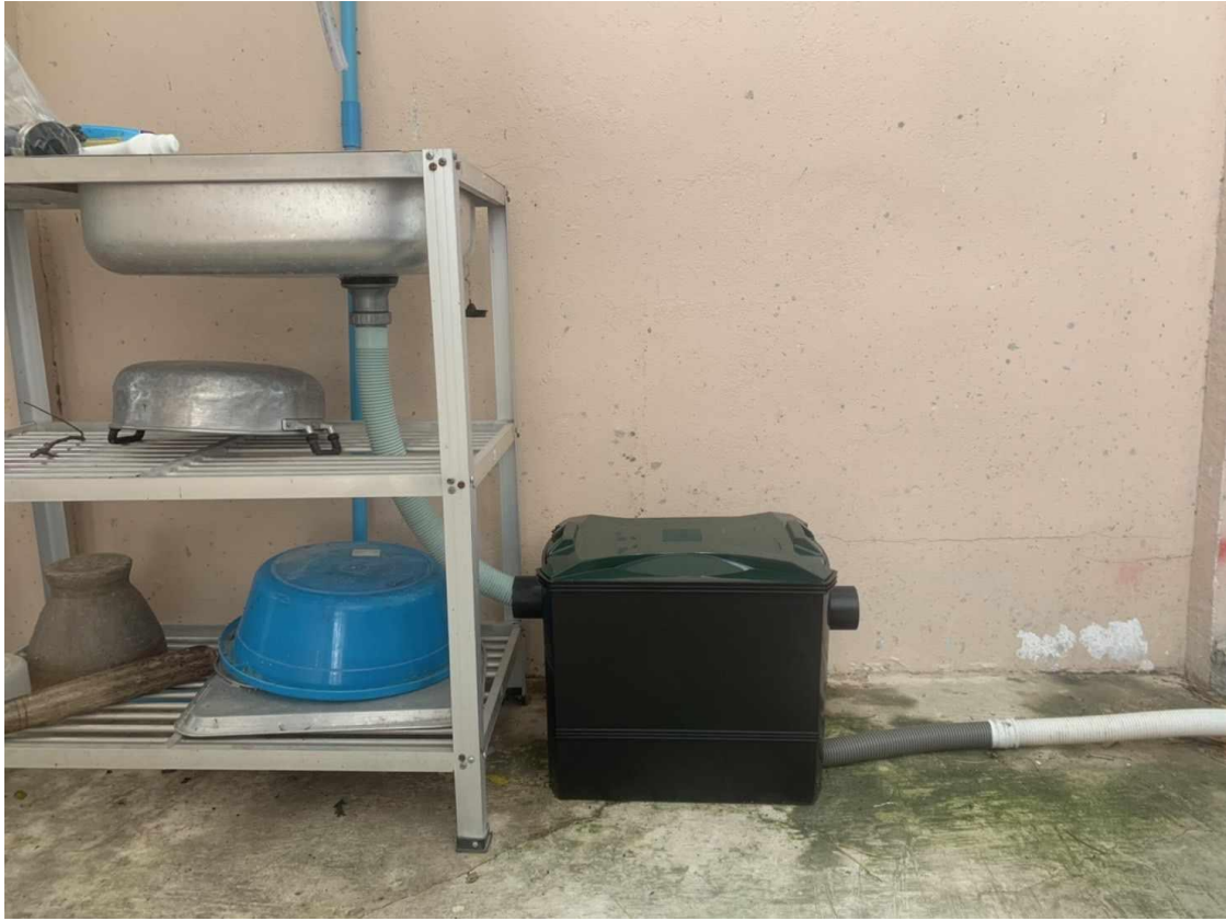
ภาพถ่ายจุดสาธิตบ่อดักไขมันครัวเรือนที่ได้ดำเนินการติดตั้ง (นาร่อง)
