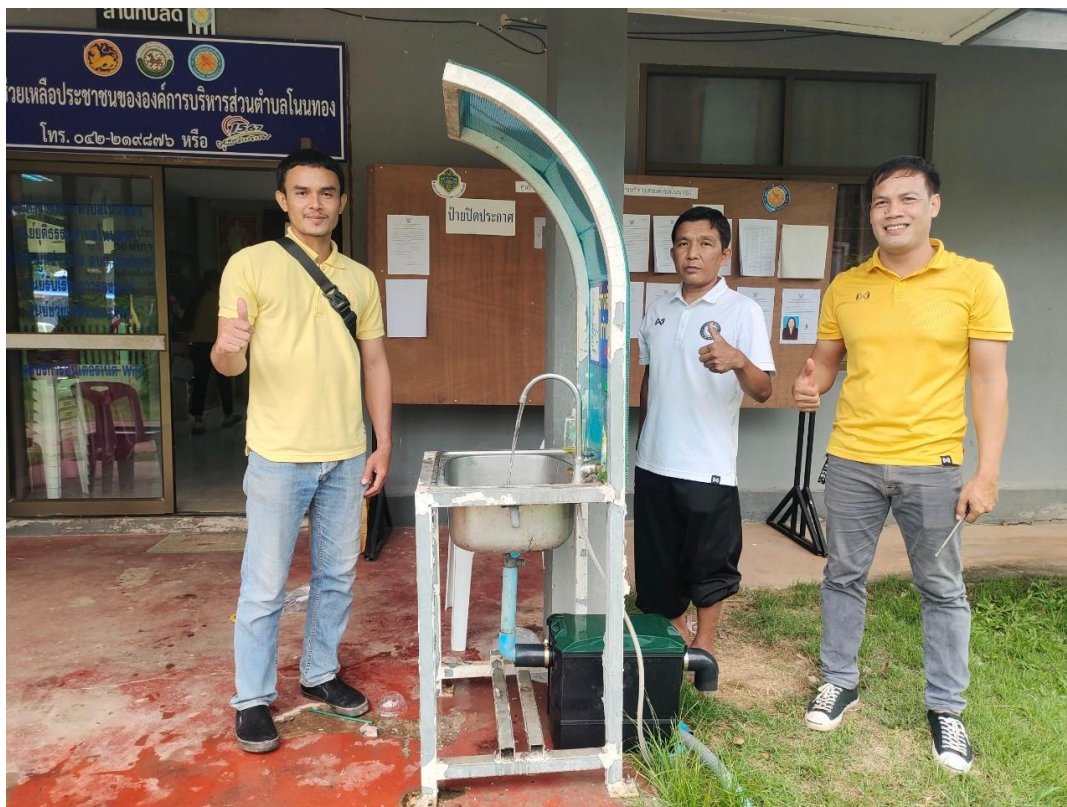
ภาพถ่ายการติดตั้งบ่อดักไขมัน สำนักงานองค์การบริหารส่วนตำบลโนนทอง
